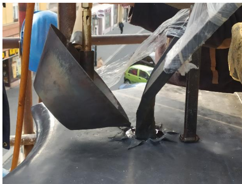
zpětná montáž kotevního systému sochařské výzdoby
