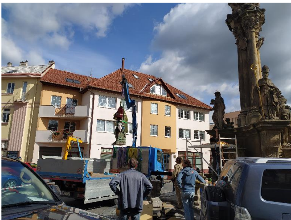
demontáž sochařské výzdoby Sloupu se sousoším Nejsvětější Trojice
