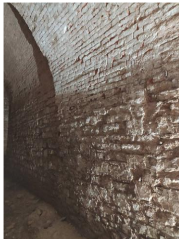
sklepní prostory po provedení sanačních prací - po otlučení omítek v roce 2020
