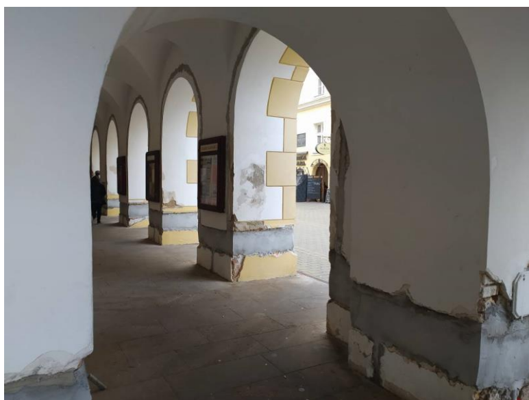
I. etapa sanace vlhkého zdiva budovy radnice v Kroměříži
