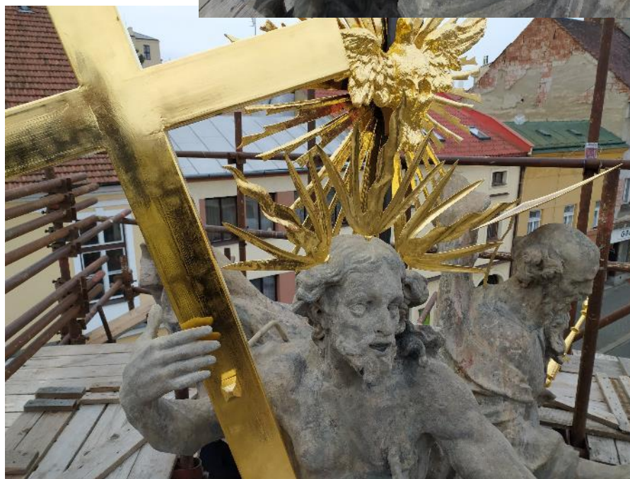
zpětná montáž sochařské výzdoby a kovových prvků
