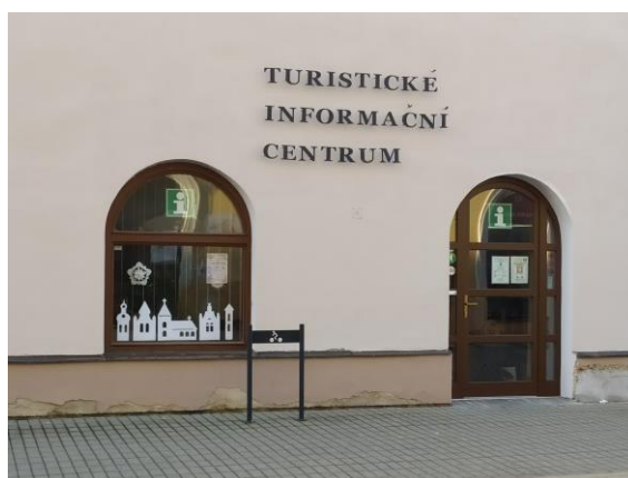
nově osazené vstupní dveře do informačního centra
