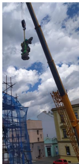
demontáž sochařské výzdoby Sloupu se sousoším Nejsvětější Trojice
