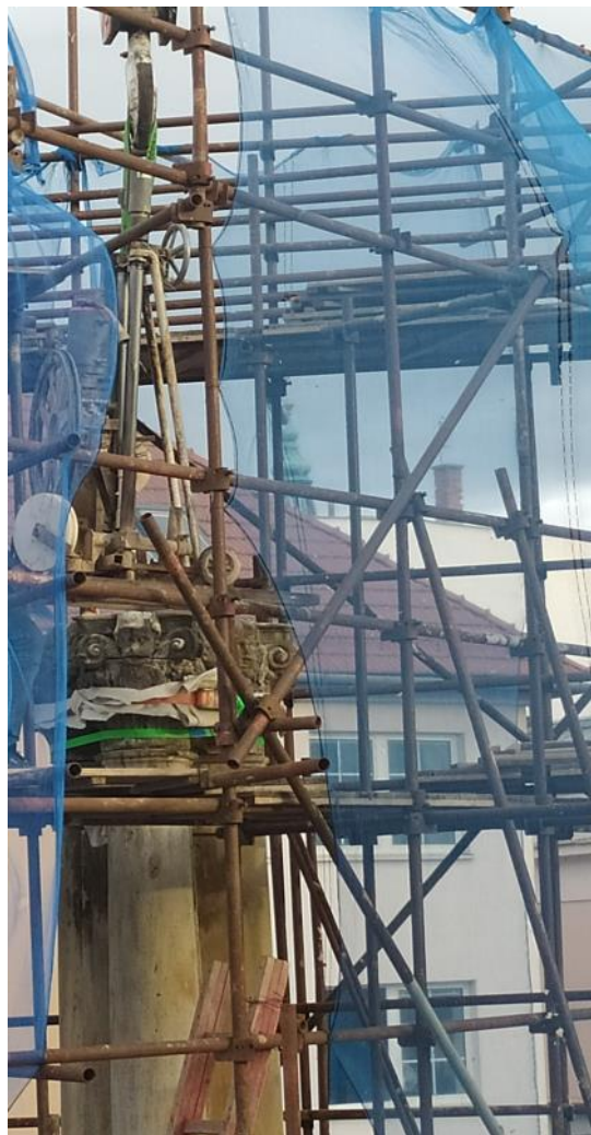
demontáž hlavice dřívku sloupu
