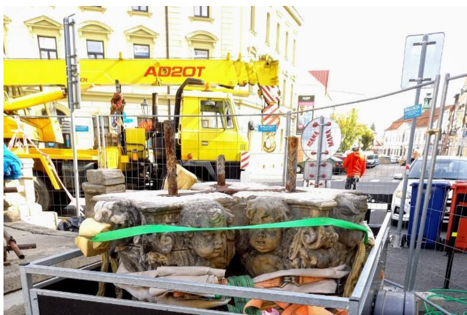
demontáž sochařské výzdoby Sloupu se sousoším Nejsvětější Trojice
