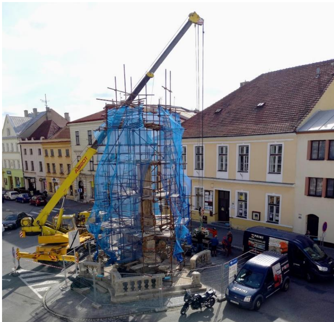
Demontáž sochařské výzdoby Sloupu se sousoším Nejsvětější Trojice
