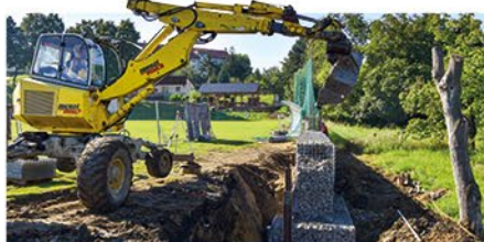
MĚSTO DOKONČUJE OPRAVU HRISTĚ V TĚŠNOVICÍCH
