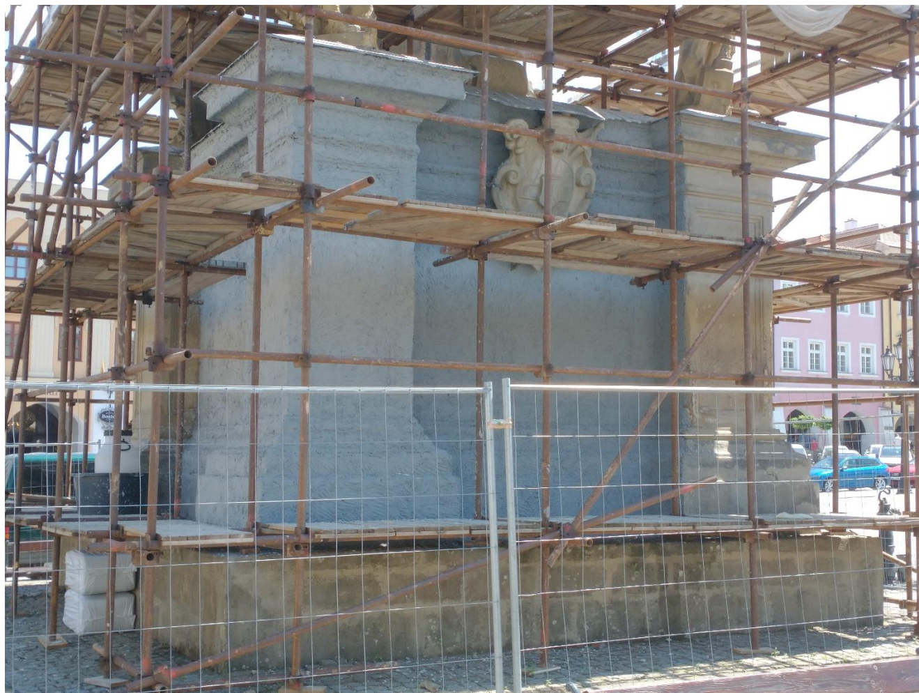
Fotodokumentace z realizace prací 04/09 2021
