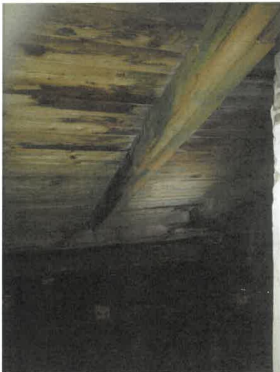
Poškozené části střešní konstrukce – podbití střešního pláště
