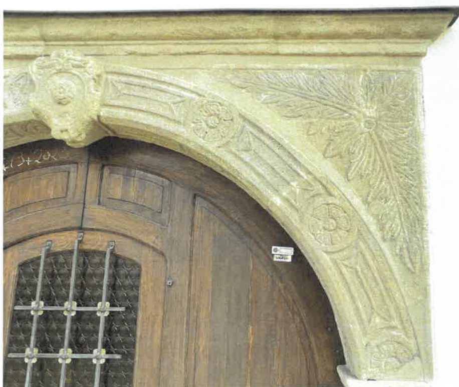
Detaily horní části portálu (cviklů) – prokreslující se tmely z předchozích oprav
