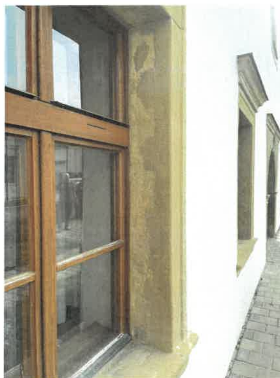
Detail levé stojky okenního ostění Detaily nadpraží a parapetní římsy ostění
