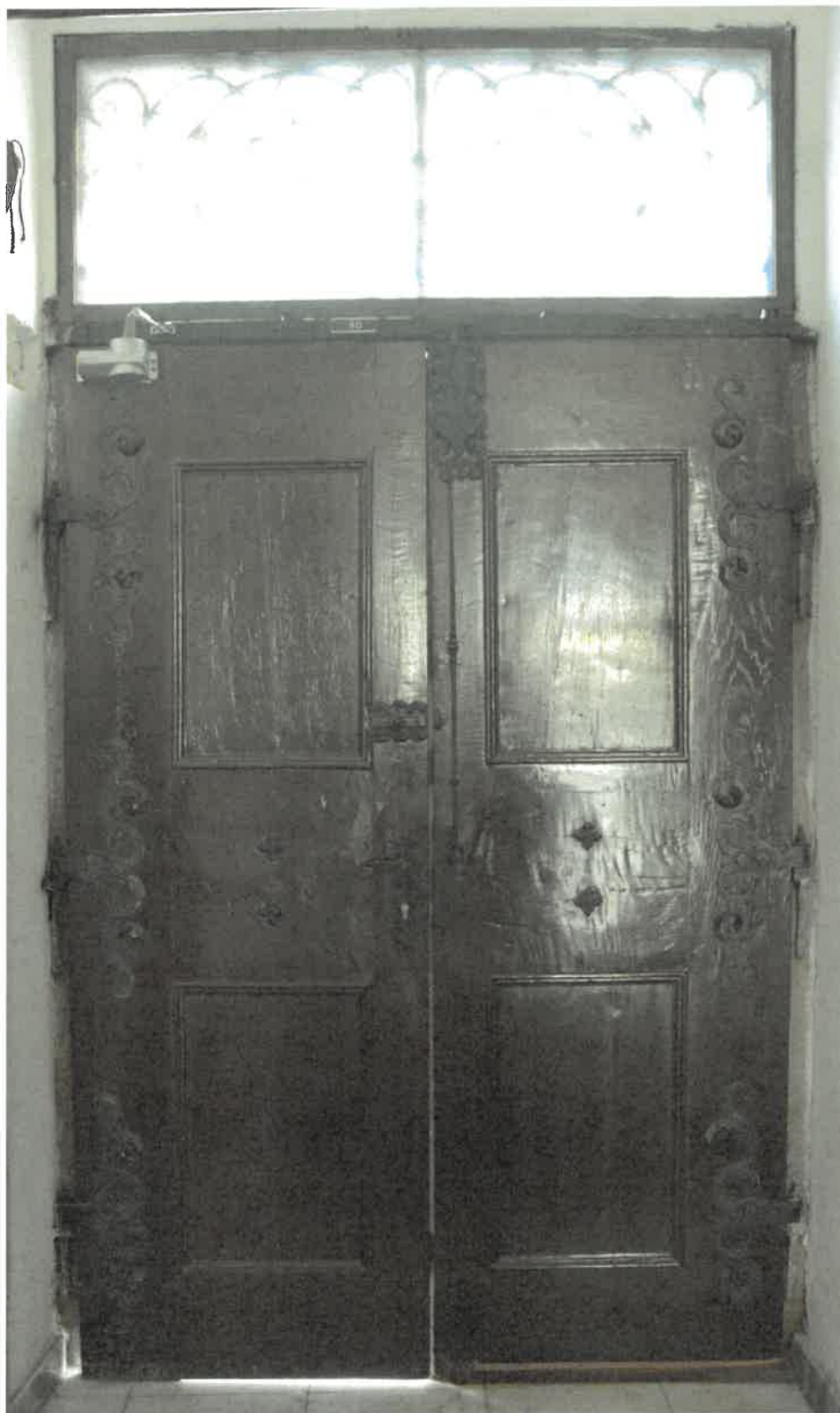
Celkový pohled na vnitřní část dvoukřídle dřevěné výplně dveří
