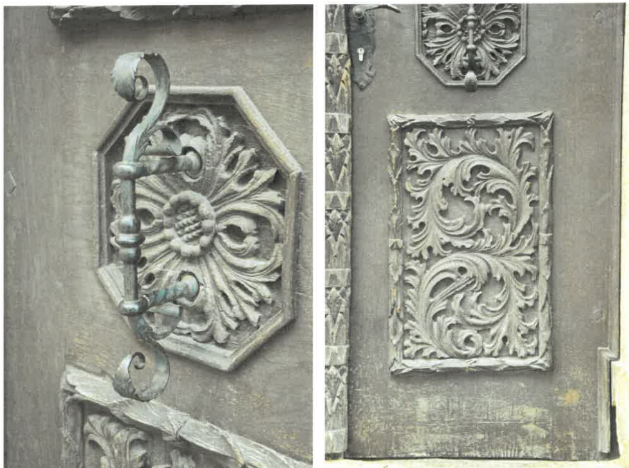
Detail autentického držadla pravého dveřního křídla.
