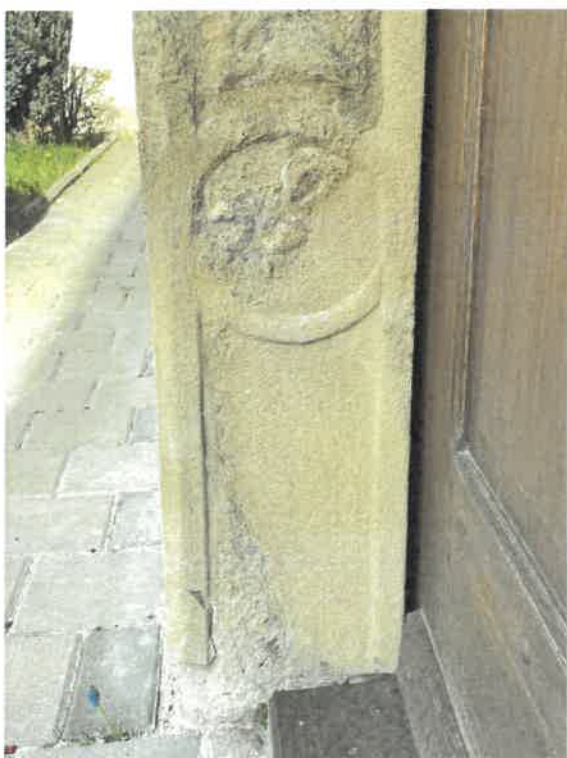
Detail levé a pravé stojky portálu – ve spodní části stojky ve styku s terénem koroze pískovce zapříčiněná vzlínavou vlhkostí a s tím spojeným předpokládaným zasolením
