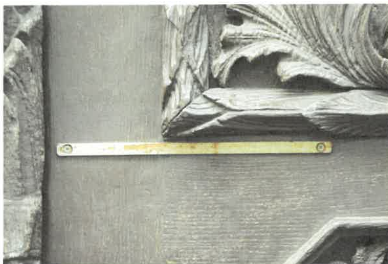
Detail střední vnější části levého křídla s kovovým druhotným doplňkem
