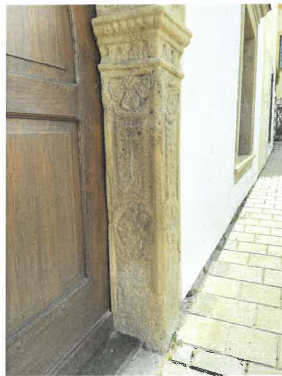
Detail levé a pravé stojky portálu – ve spodní části stojky ve styku s terénem koroze pískovce zapříčiněná vzlínavou vlhkostí a s tím spojeným předpokládaným zasolením
