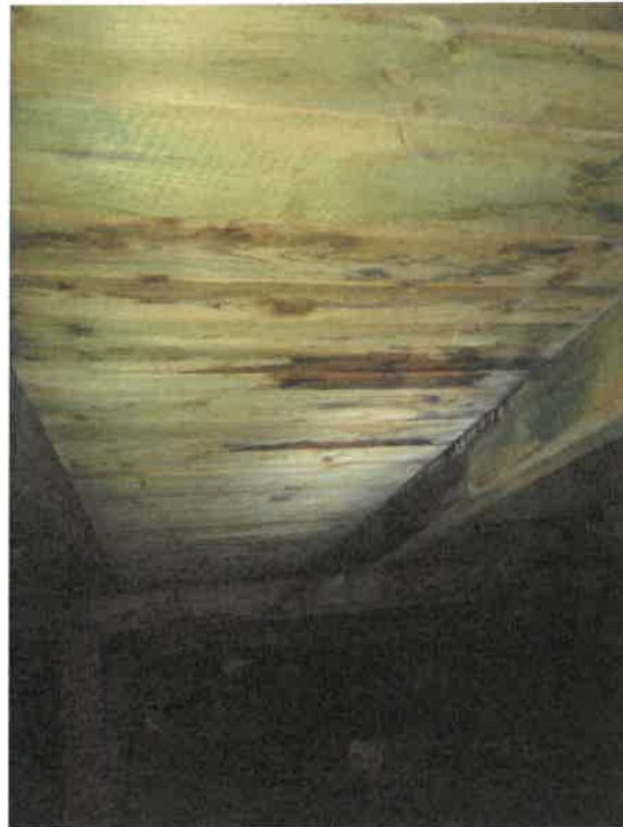
Poškozené části střešní konstrukce – podbití střešního pláště
