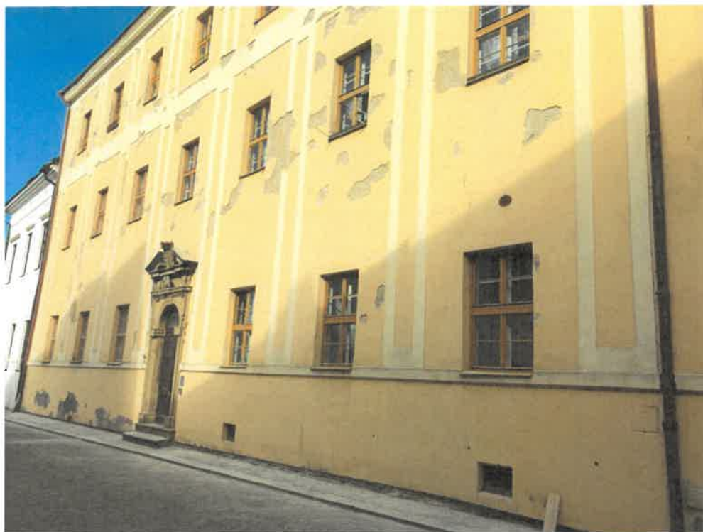
Pohled na boční fasádu z ulice Pilařova
