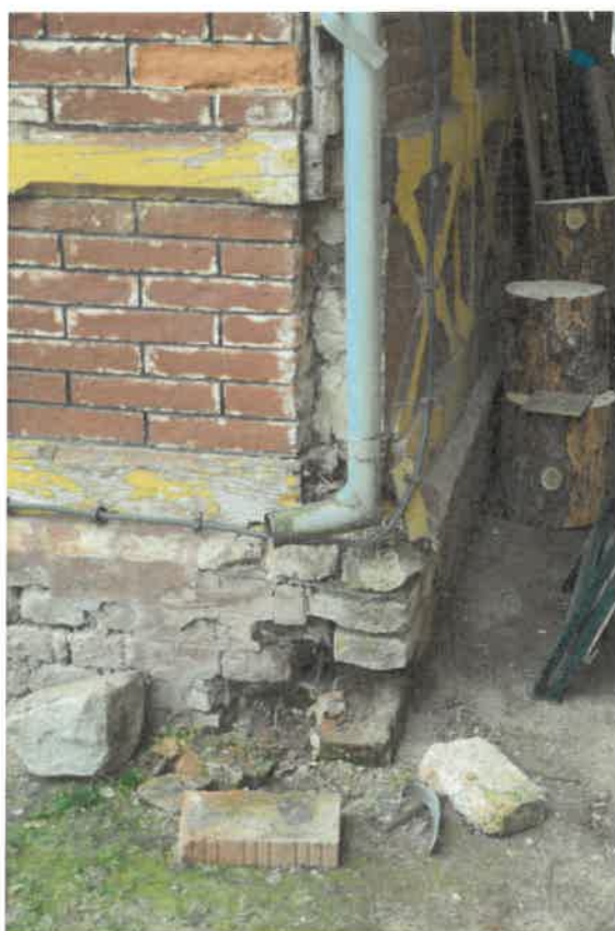
Detaily poškození objektu - cihelného soklu a původního nosného svíslého trámu
