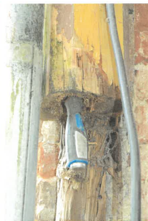
Detaily poškození objektu - cihelného soklu a původního nosného svíslého trámu
