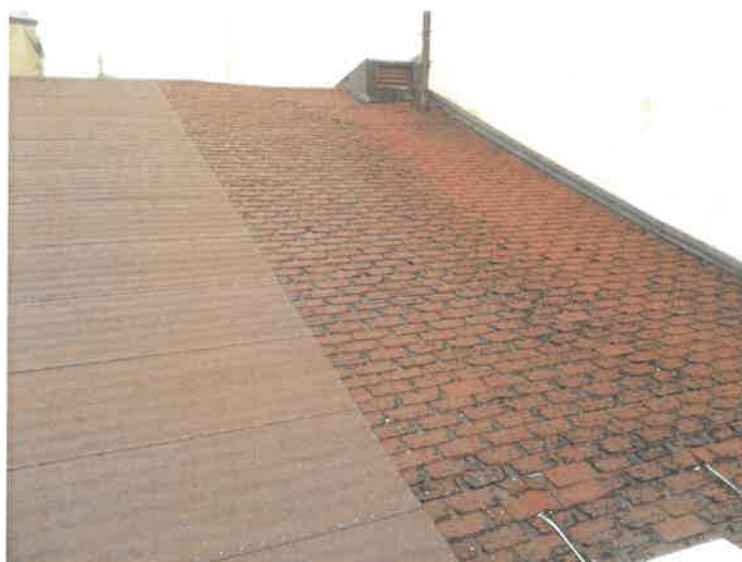
Stávající stav střešní krytiny objektu
