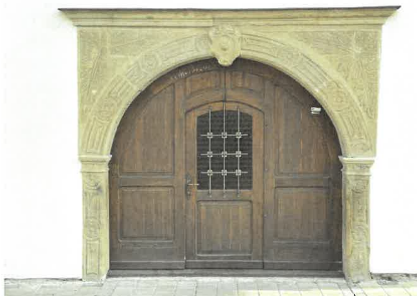
Celkový pohled na vstupní kamenný portál domu č. p. 1492
