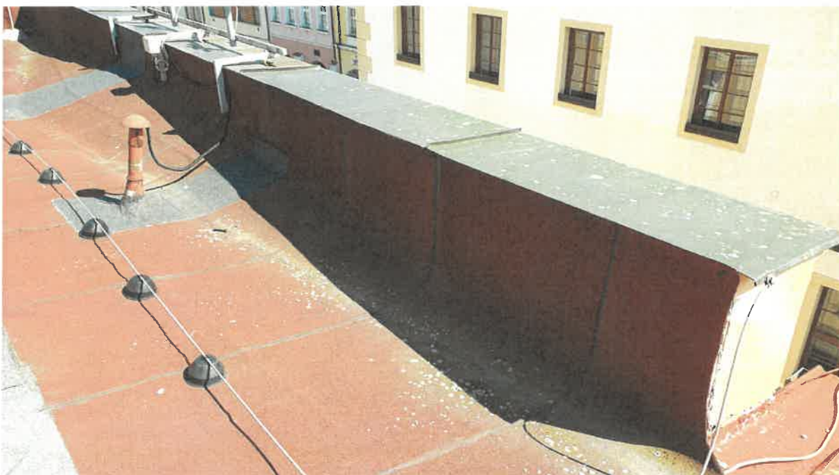
Stávající stav střešní krytiny objektu
