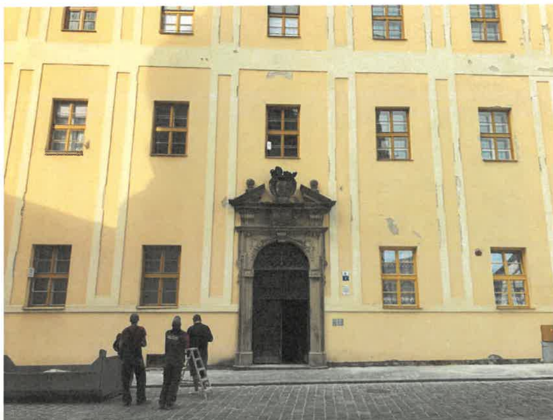
Pohled na fasádu hlavního vstupu
