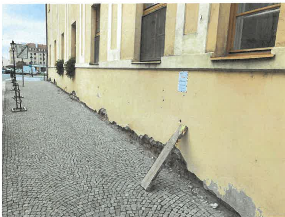
Celkový pohled na fasádu z ulice Jánská a fasádu hlavního vstupu
